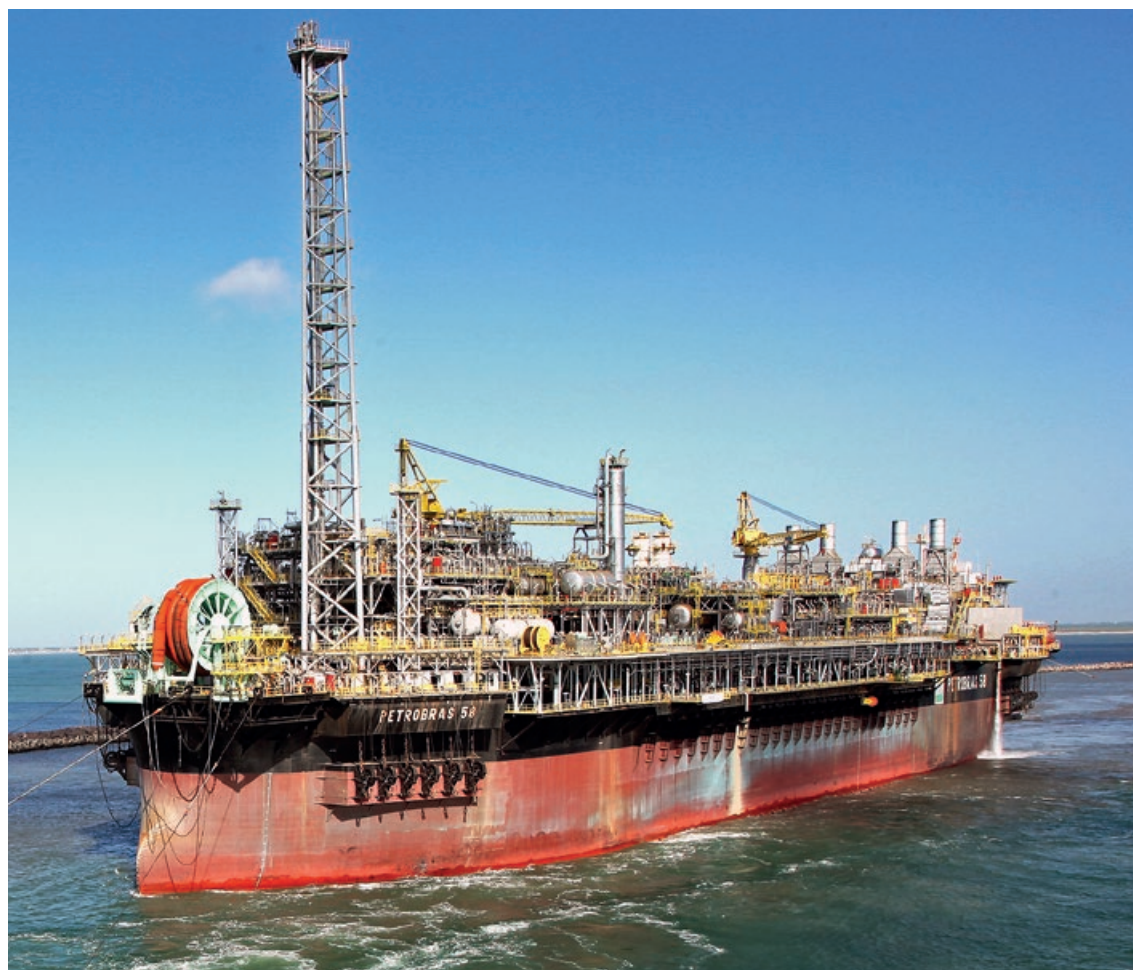
FPSO P-58 (Agência Petrobras)
