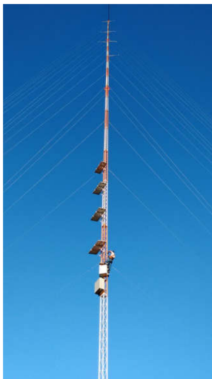
Fig1 – Torre Anemométrica Trelaçada
