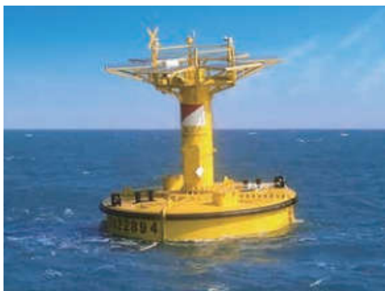
Fig.6 – Bóia Anemométrica Implantada
